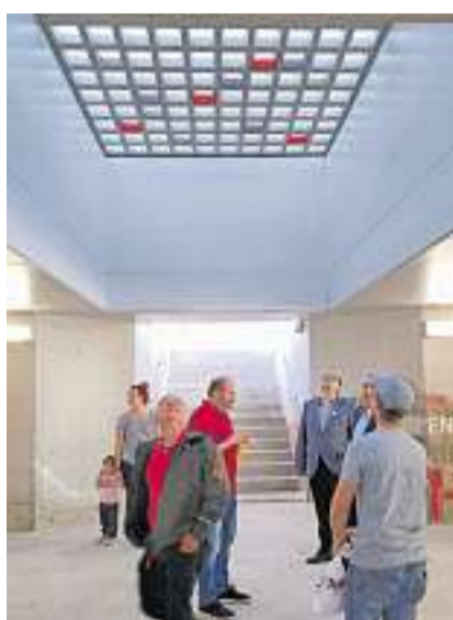
Speziell ist auch die lichtdurchlässige Decke zwischen den Gleisaufläufen.
