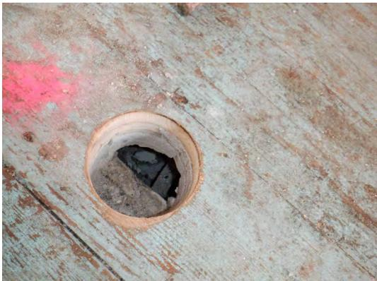
Abb. 15: Bohrloch Bodenaufbau 1. DG,
