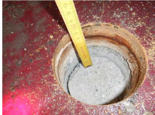
Abb. 14: Bohrloch Bodenaufbau 1. DG
