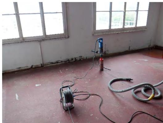
Abb. 10: Durchführung Kernbohrungen
