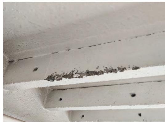
Abb. 18: Beprobung Betonrippendecke
