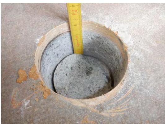
Abb. 17: Bohrloch Bodenaufbau 2. OG
