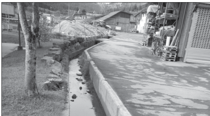
Abbildung 2: Kanalisierter Karlismattbach und Geissbergbach unterhalb Dorfstrasse
