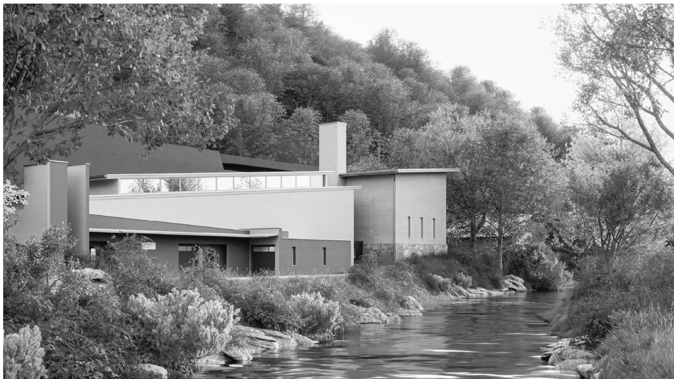
Abbildung: Krematorium nach Abschluss der Umbauarbeiten im Juni 2024
